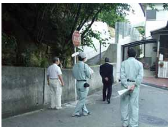
西山南端の県による砂防壁を見る
